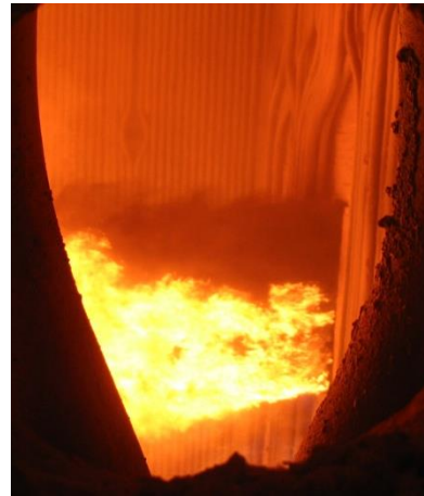
Общий вид котла
